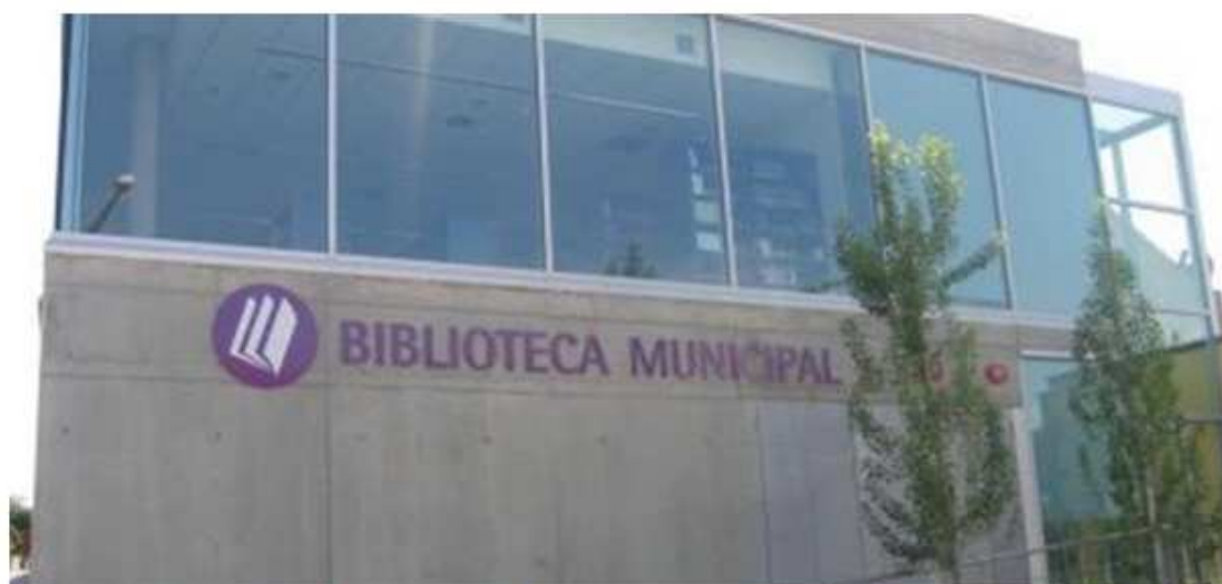
Biblioteca Municipal de l'Arboç. Foto: Aj.l'Arboç
