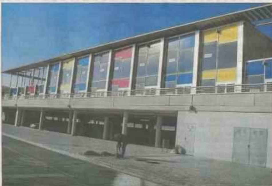
Los locales municipales en el puerto de Segur que nunca han tenido actividad. FOTO: AMEDT
