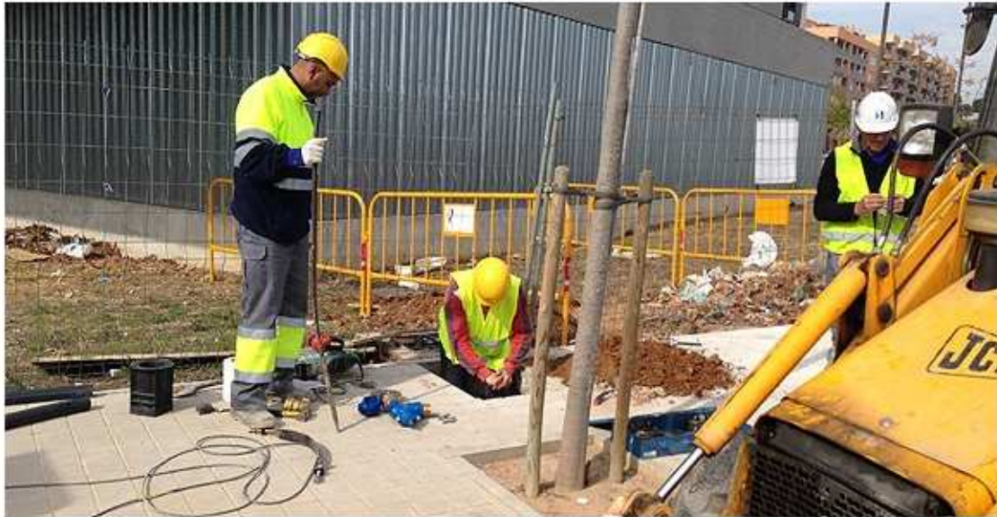
Els operaris han començat a treballar a l'exterior de la Pere Anguera aquest dilluns. Foto: Guillem RS.
