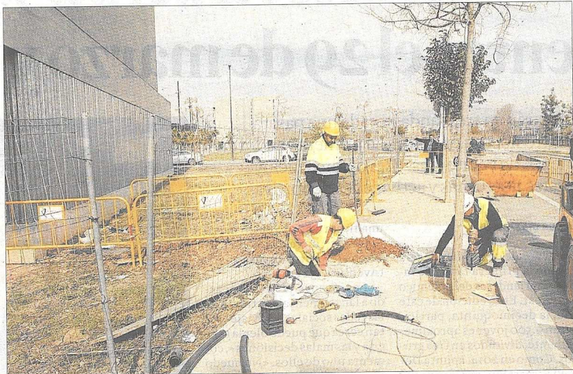
Les obres van començar amb la fibra òptica i la urbanització de la parcel·la ubicada a Mas Iglesias. FOTO: PERE FERRÉ
