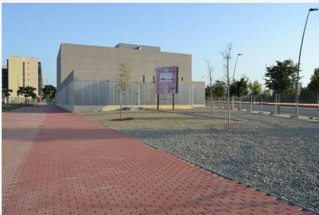
Imagen del entorno de la Biblioteca Pere Anguera después de finalizar las obras de mejora. Foto: Ajuntament de Reus
