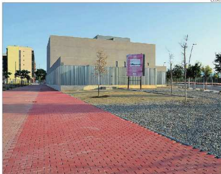
Exterior de l'equipament reusenc, al barri de Mas Iglesias.
