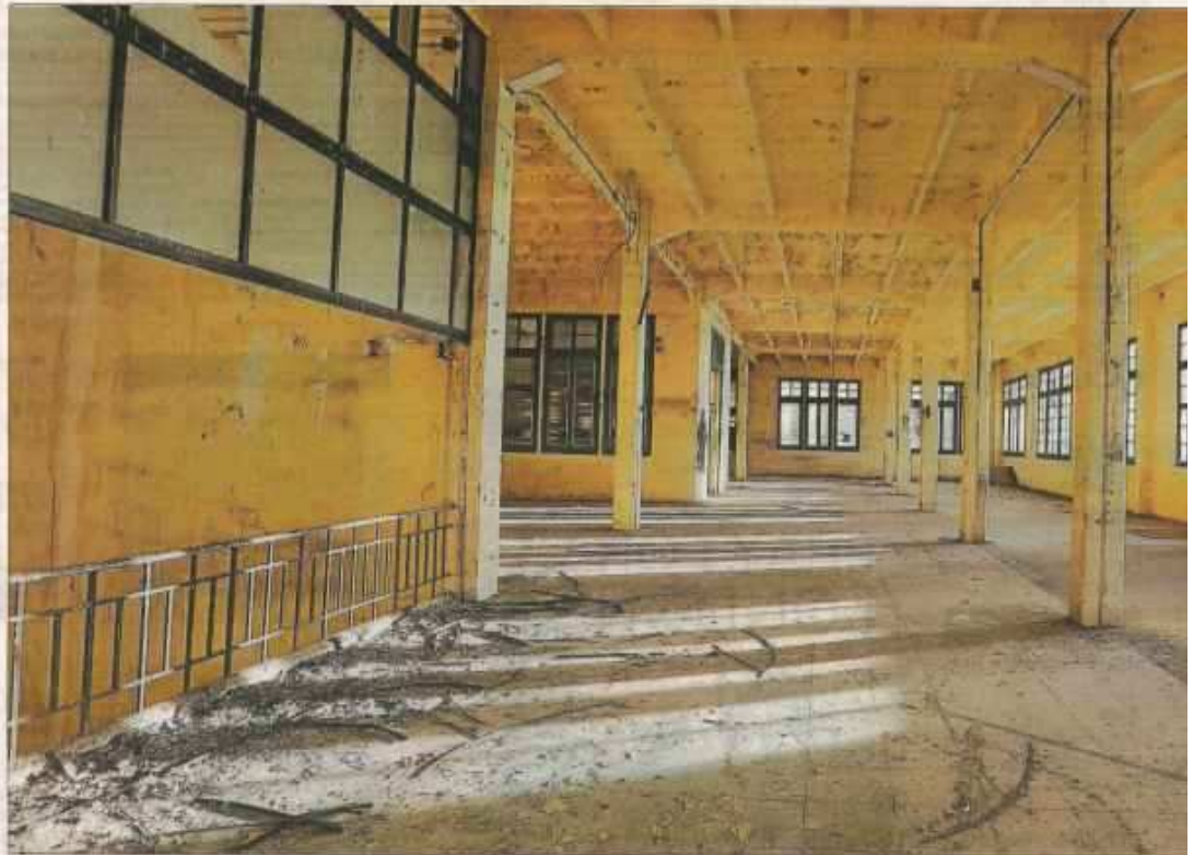
Imagen reciente del aspecto que ofrece en la actualidad el interior de la antigua fábrica de tabacos, vacío desde el año 2007. FOTO: PÈRE FERRE
