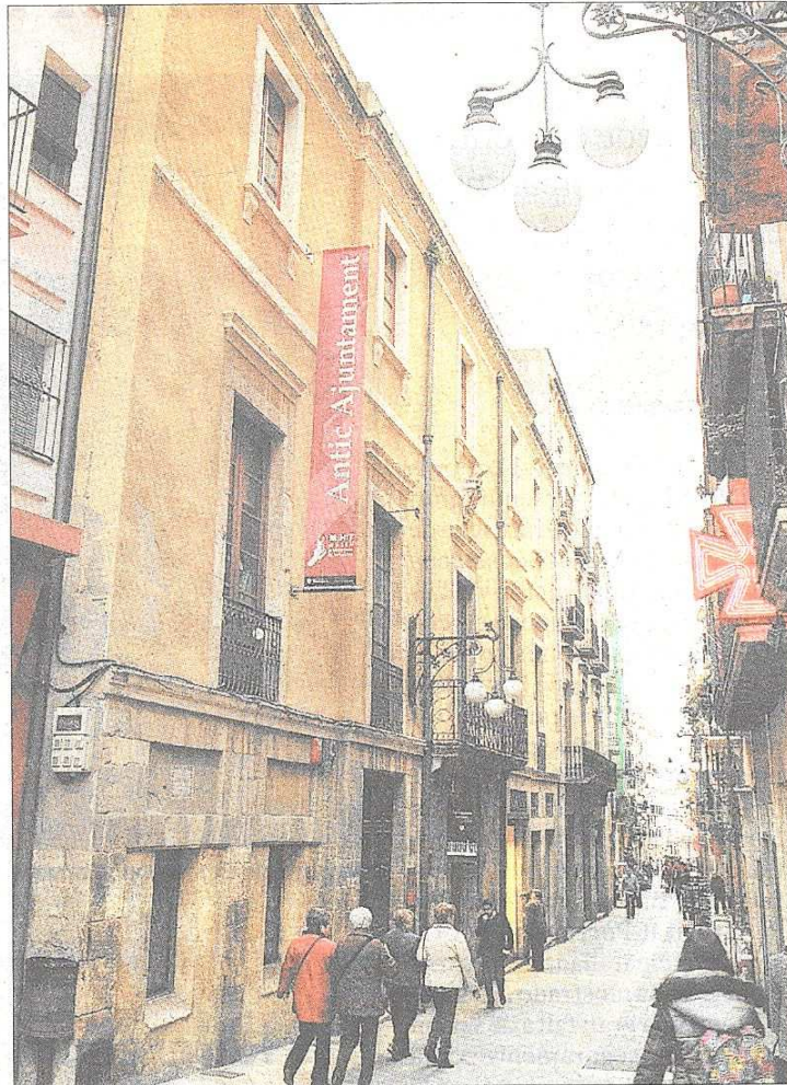
Imagen de ayer del inmueble situado en la calle Major que será la sede principal del nuevo servicio público del Ayuntamiento. FOTO: PERE FERRÉ
